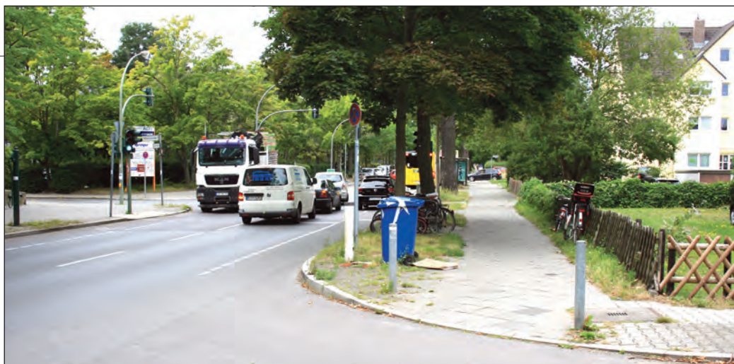
Ab hier, wo die Krontalstraße in die Groß-Ziethener-Straße mündet, gibt es auf der Fahrbahn eine Spur für Radler (gestrichelte Linie). Fotos: Bothe
