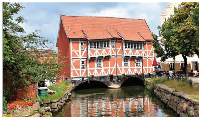
Das Gewölbe über der Grube am Lobberg nahe Hafen.
